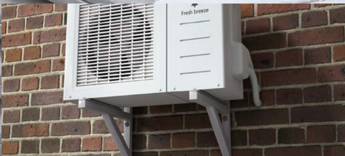
INSTALLATION DE CHAUFFAGE ET PLOMBERIE
